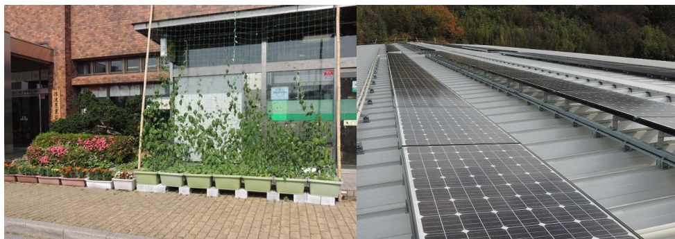
写真：本店前の緑のカーテンと畑野倉庫の太陽光パネル
