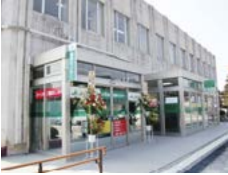
金井支店1階にオープンした新・融資センター
